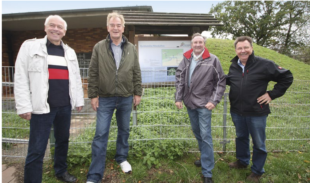
Ortstermin in Sachen Wasserversorgung: Bürgermeister Albert Ungermann, Siegfried Rückriegel, Geschäftsführer der Stadtwerke Gelnhausen, Bernd Becker und Helmut Bluhm vor dem Hochbehälter Altenhaßlau
